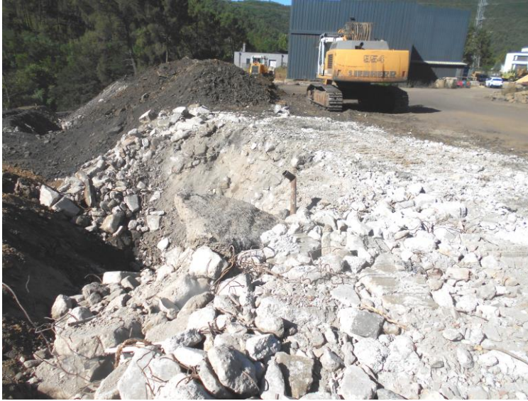
Figure 5 : Tranchée centrale le 6 juillet
