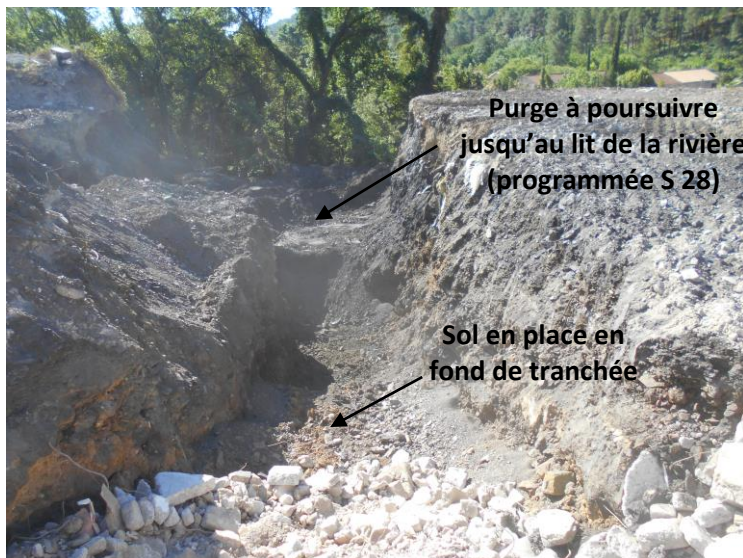
Figure 6 : Tranchée « Est » le 6 juillet
