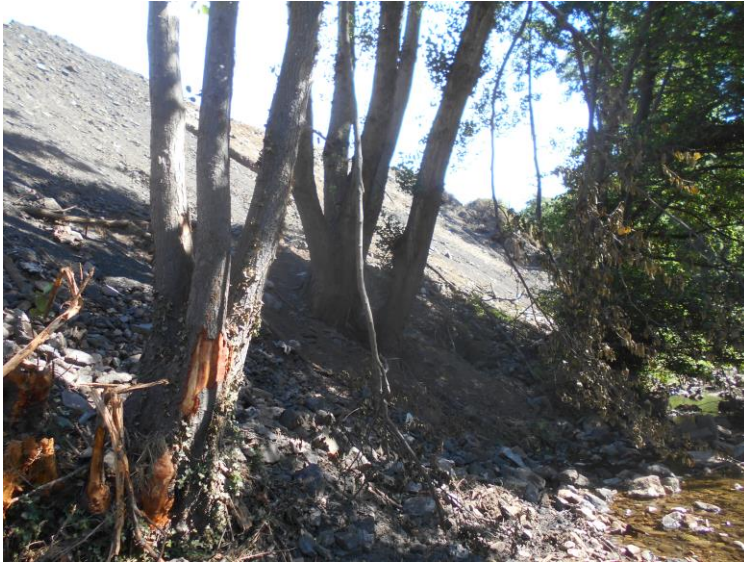
Figure 8 : Talus en rive gauche de l'Auzonnet
